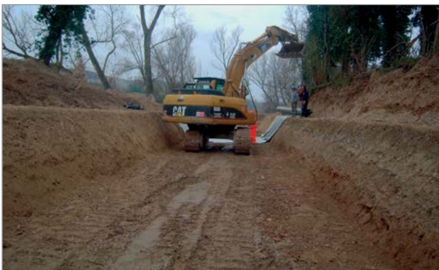
Escavazione sagoma canale
