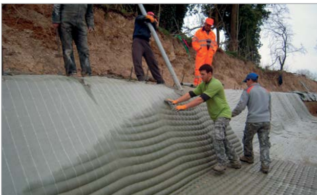
Riempimento con malta cementizia
