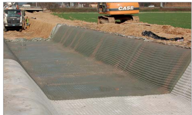
Fasi di riempimento appena terminate
